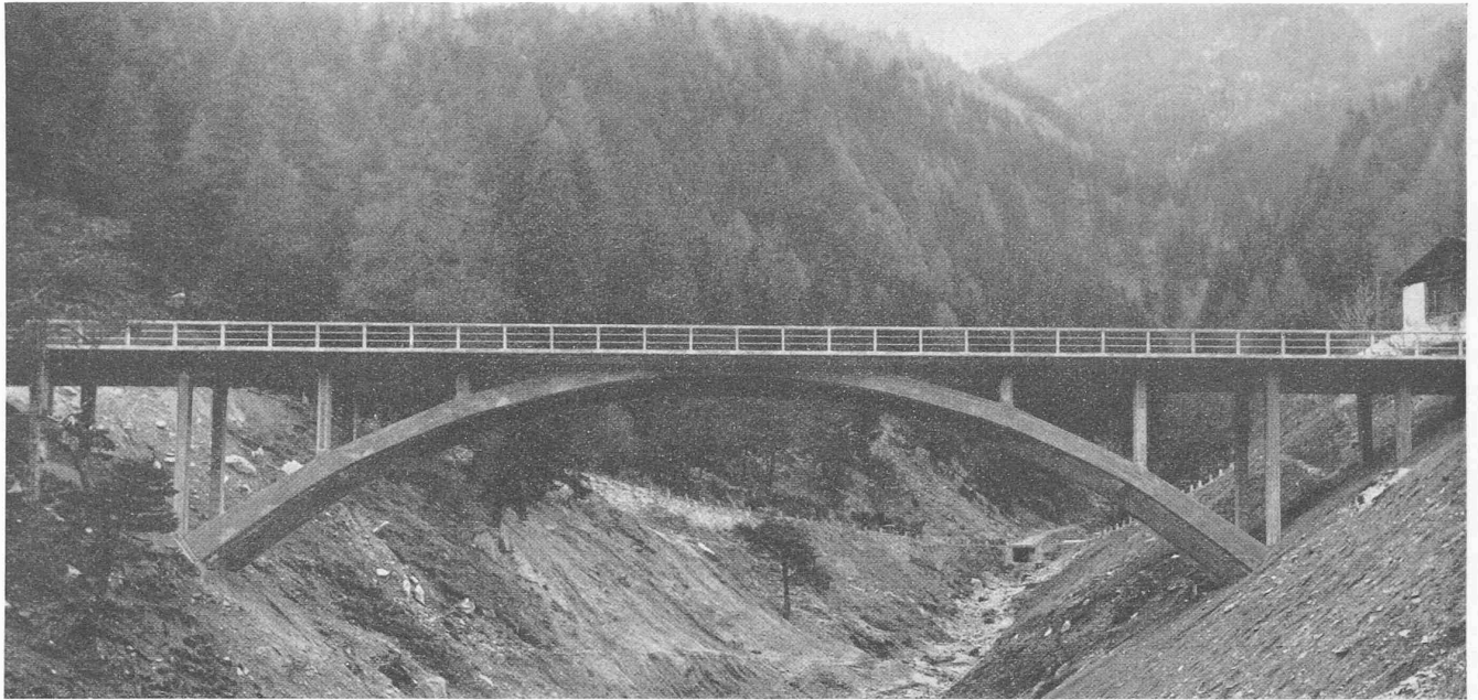
Fig. 1. — Pont de Laxgraben. Vue générale en amont.
