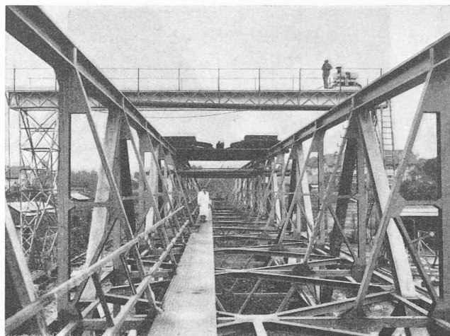
Fig. 3. — Vue en bout du pont lors des essais. 1
