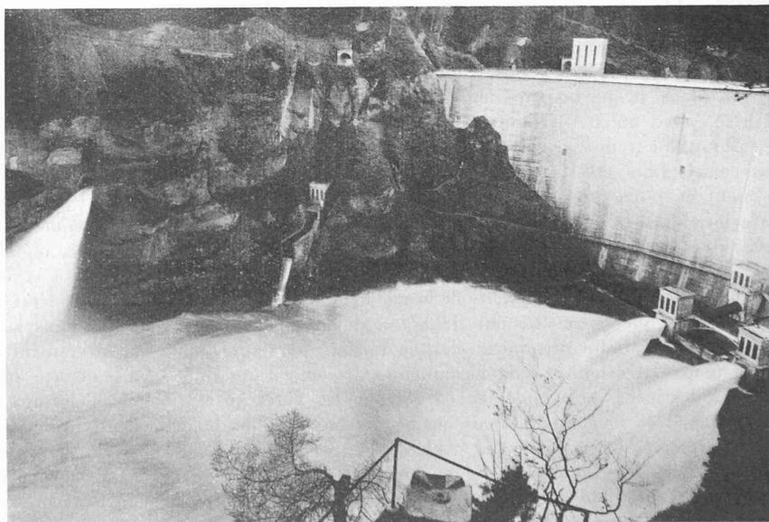
Fig. 17. — Evacuation d'une crue d'environ 550 m<sup>3</sup>/sec.
