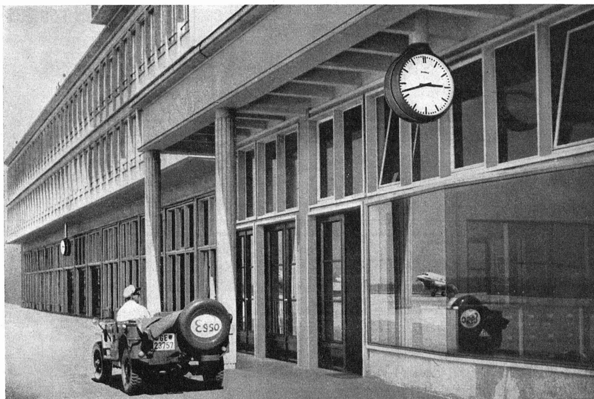
Horloges électriques FAVAG de l'Aéroport de Genève.
