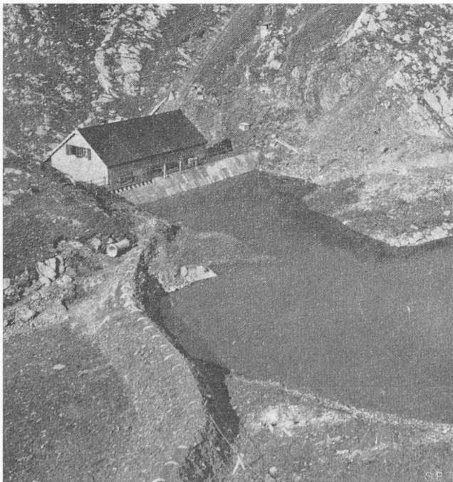
Fig. 4. — Station de pompage de Clusanfe. Au premier plan, la conduite d'amenée de la Sauffla occidentale.
