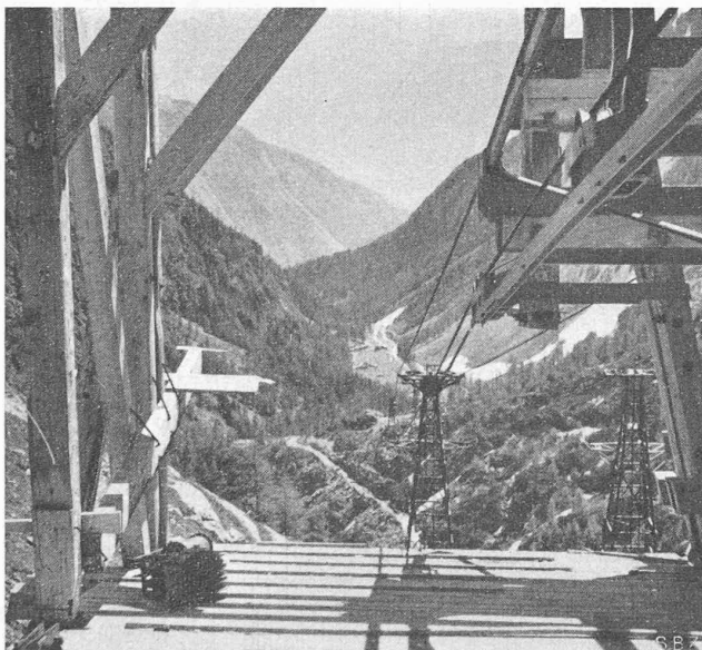
Fig. 19. — Station supérieure du téléphéage des graviers. A l'arrière-plan, le vallon des Vans.
