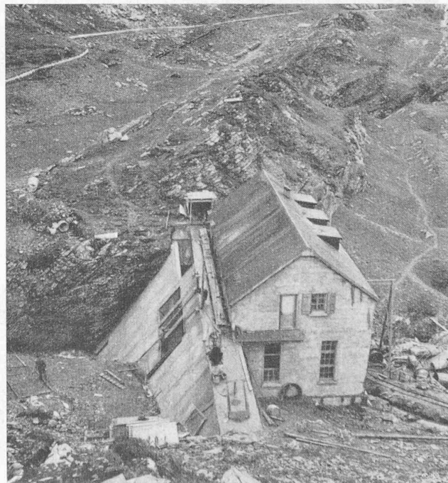
Fig. 5. — Station de pompage de Clusanfe. Au fond, la conduite d'amenée de la Sauffla occidentale.
