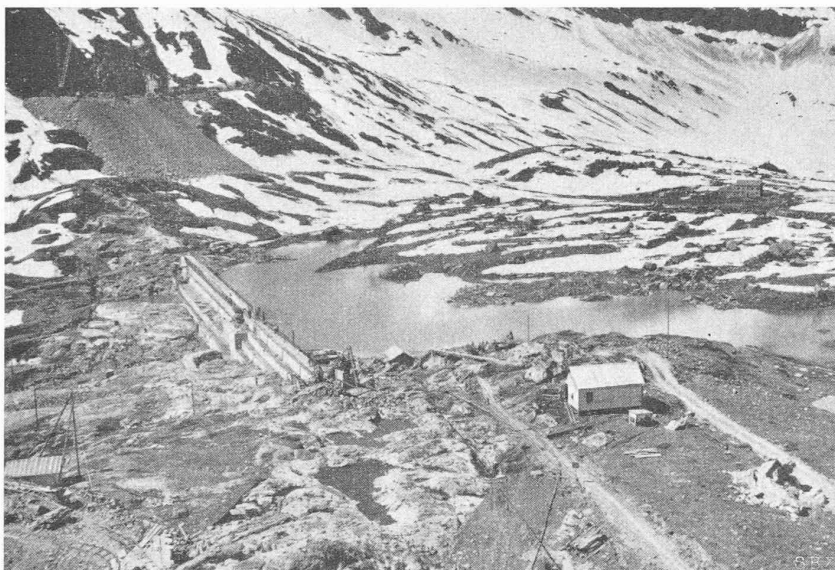
Fig. 12. — Salanfe. Barrage provisoire.
