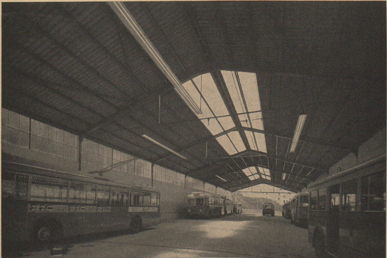
Dépôts de la Borde pour trolleybus et tramways de la Société des Tramways lausannois Constructeurs : ZWAHLEN & MAYR S. A., Lausanne
