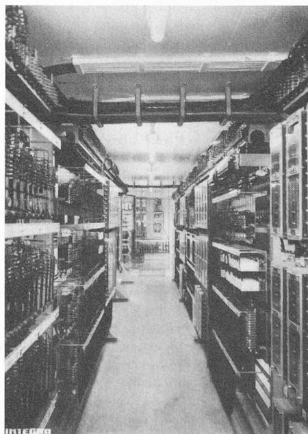
Fig. 11. — Genève-Cornavin, Poste I: Vue du local à relais. On voit à droite, au premier plan, des jeux de relais de commande d'aiguille, à connecteurs.
