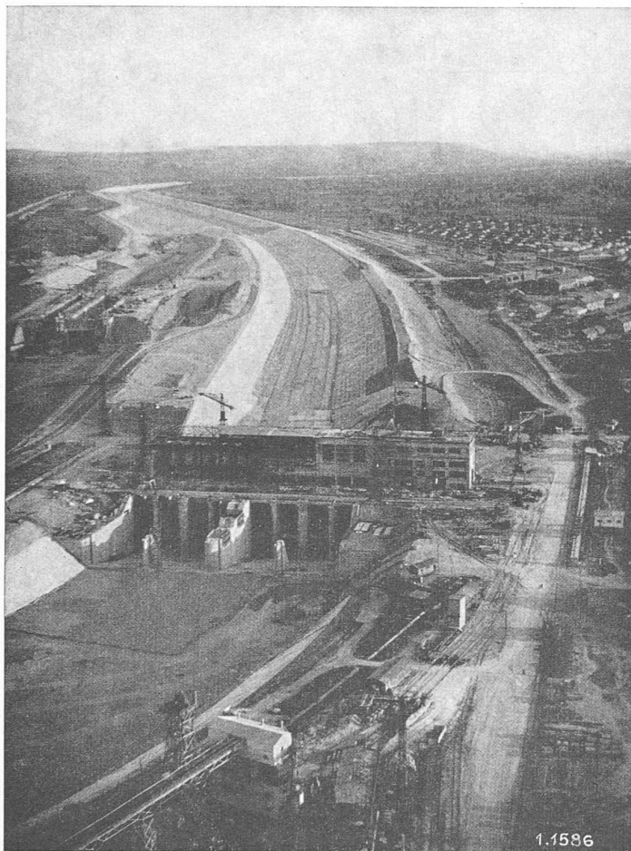
Fig. 1. — Vue aérienne de la centrale, prise dans la direction de l'amont, avec, à gauche et à l'arrière-plan, les écluses et le bassin de virage.
