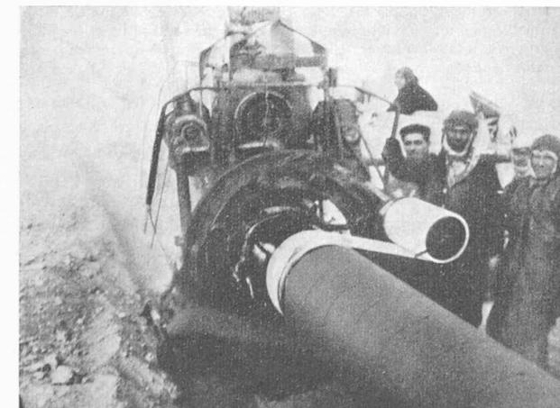
Fig. 1. — Isolation d'un pipe-line dans le Moyen-Orient.
