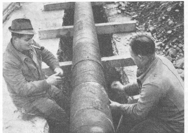
Fig. 3. — Isolation d'un joint soudé d'une conduite à gaz de la Ville de Zurich.
