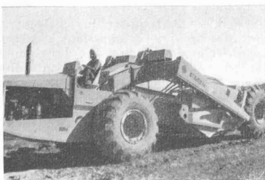
Fig. 17. — Barrage de Hirakud. Scraper Le Tourneau.
