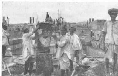
Fig. 11. — Barrage de Nangal. Chargement du béton par les hommes et transport par les femmes.
