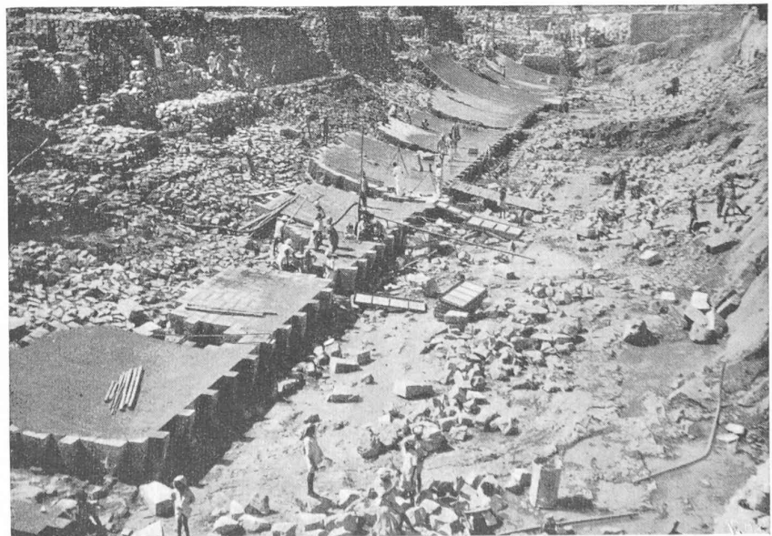
Fig. 18. — Barrage de Tungabhadra. Maçonnerie de granit, revêtement de l'évacuateur de crues.
