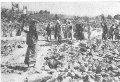
Fig. 16. — Barrage de Hirakud. Transports des matériaux d'excavation.
