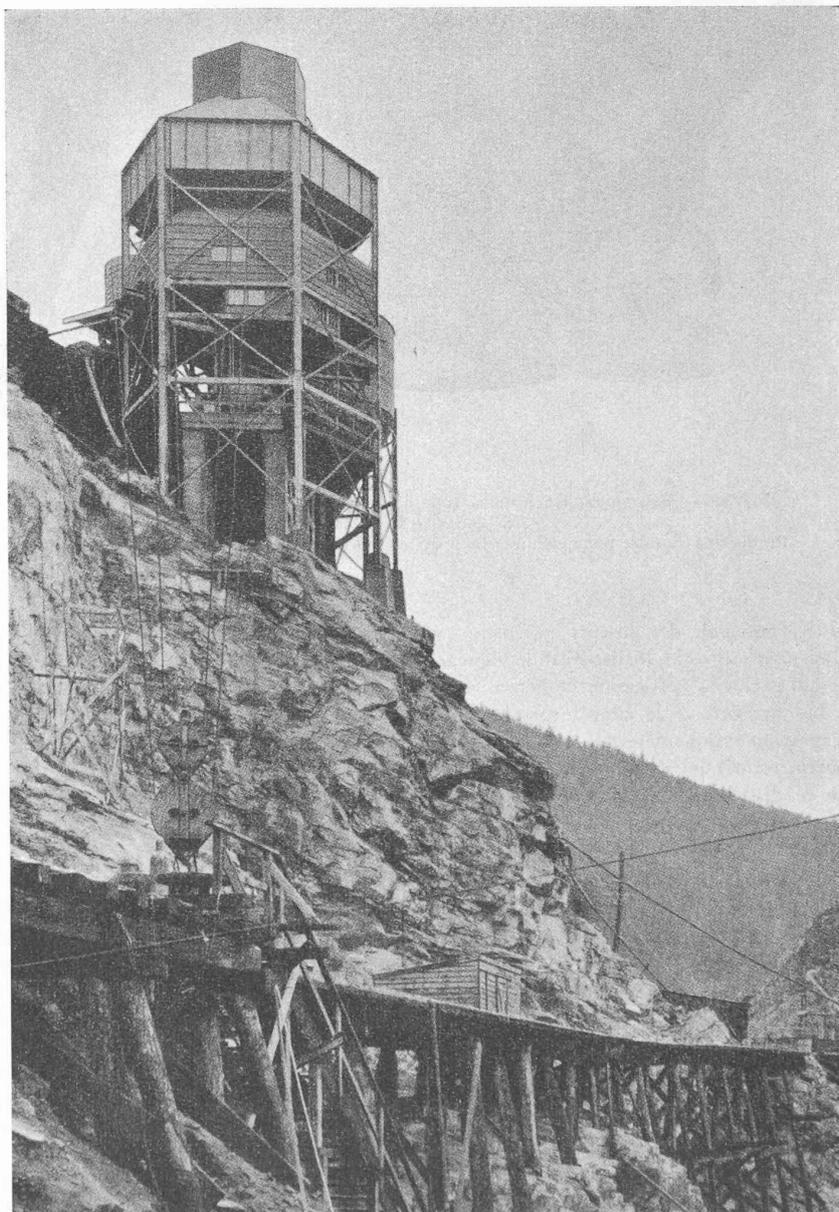
Fig. 1. — Tour hexagonale Winget-Johnson-Koehring équipée de 2, 3 ou 5 mélangeurs de 3000 litres chacun à la gâchée.
