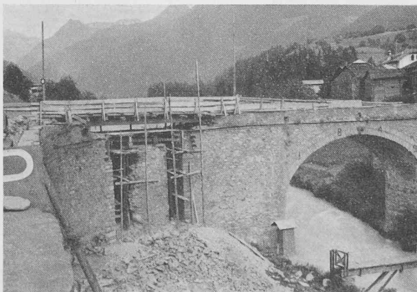
Fig. 6. — Percement de la culée du pont existant.
