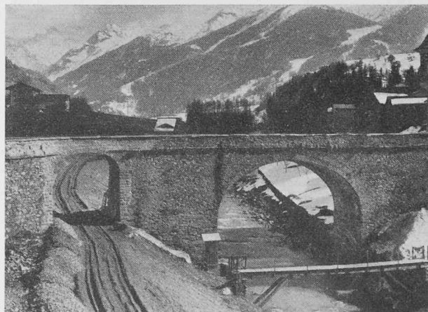
Fig. 7. — Le tunnel terminé.
