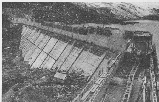
Fig. 1. — Vue du Barrage de Salanfe en construction.
