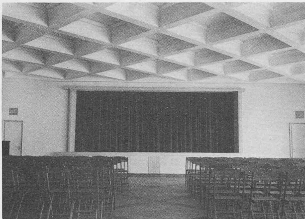
Fig. 5. — Vue du plafond.
