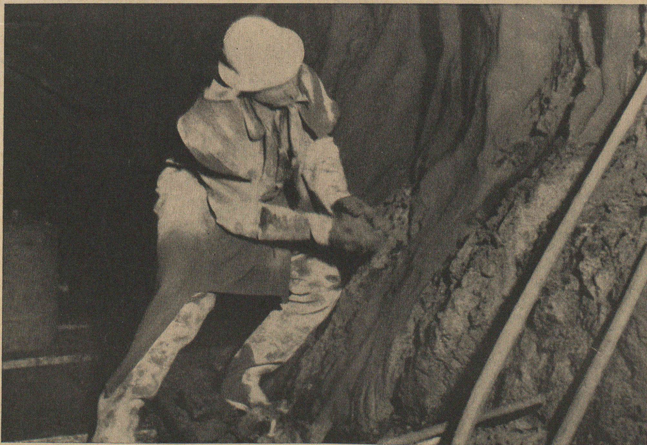
Usine hydro-électrique de la Maggia, étanchéité préalable de la conduite forcée de Verbano avec BARRA RAPIDE U.
