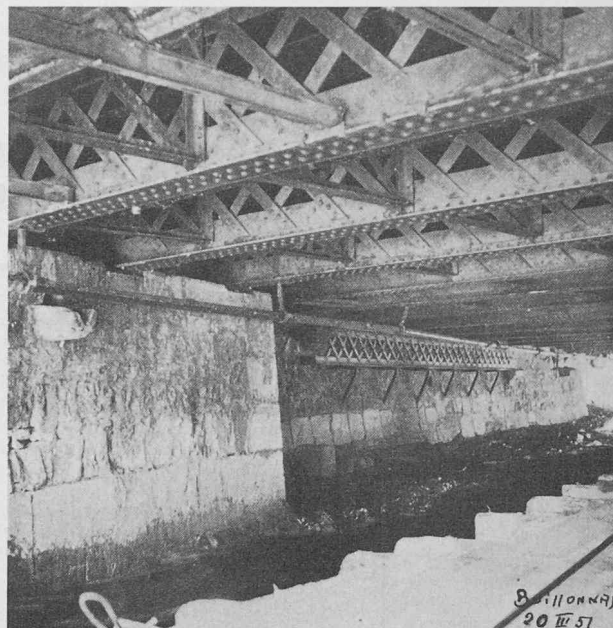
Fig. 3. — Vue par-dessous de la poutraison de l'ancien pont B. D. et l'ancienne culée rive gauche.
