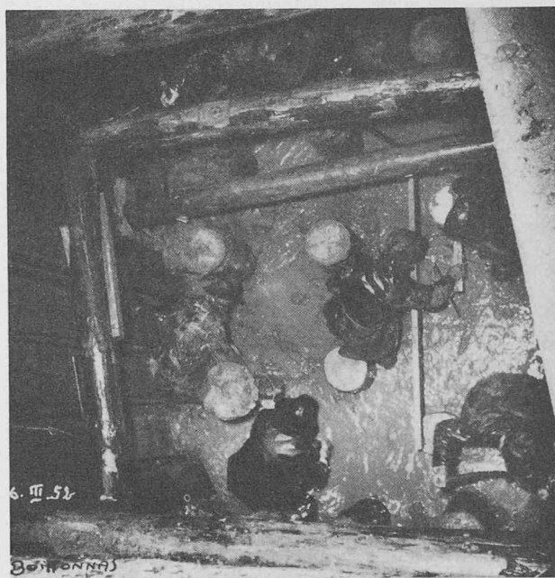
Fig. 13. — Le battage des pieux terminé.
