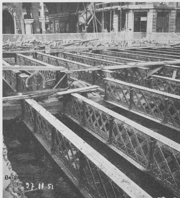
Fig. 9. — Reconstruction du pont B.G. L'entreprise a coupé les anciennes poutres sur les piles et les abaisse pour servir d'appui au coffrage de la nouvelle dalle.
