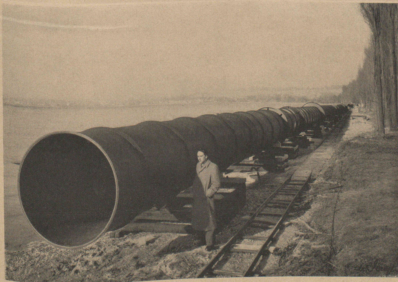
Conduite d'adduction diamètre 1600 mm. — Constructeur : ZWAHLEN & MAYR S. A., Lausanne
