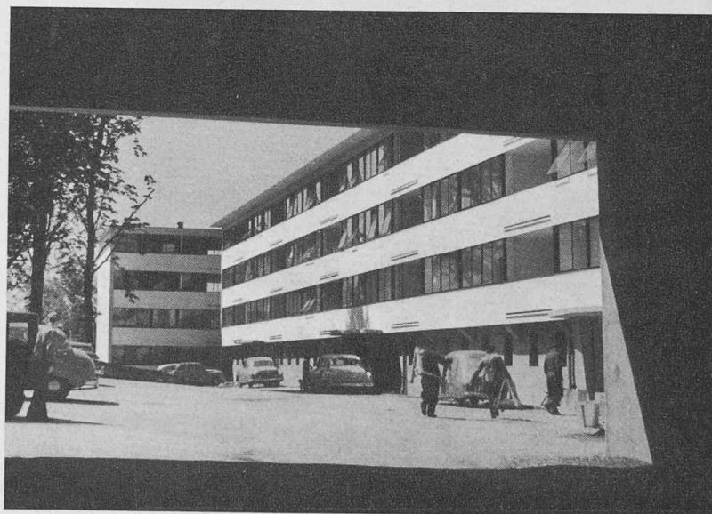
Fig. 38. — Bâtiments 2 et 3 vus depuis le bâtiment 4.
