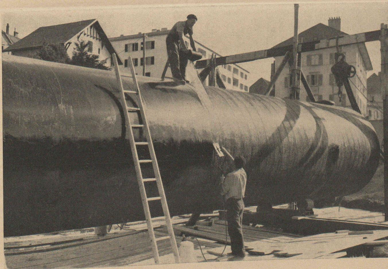
Isolation Waberit avec tissus de verre imputrescible « VETROTEX-ARMATURE » d'une citerne à mazout
