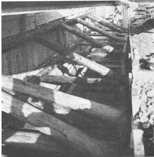
Fig. 14. — Boisage de la fouille d'une des culées.
