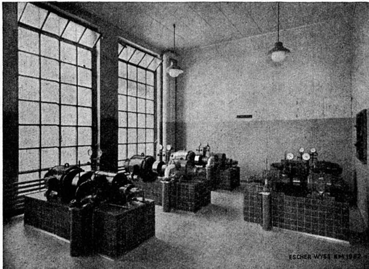
5 compresseurs «ROTASCO» pour la réfrigération
