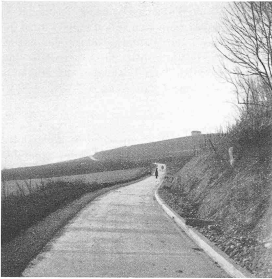
Fig. 3. — Route en béton dans le coteau de Bernex. La route est construite avec un devers de 4 % et coupe le bassin d'alimentation en deux parties.
