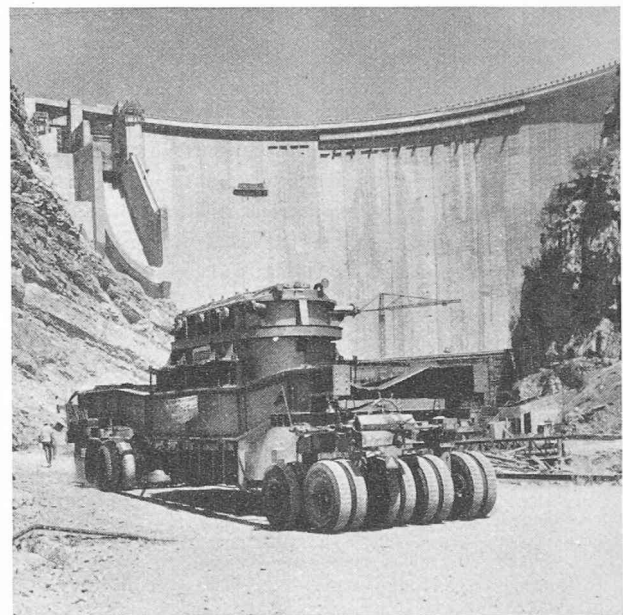
Fig. 6. — Arrivée au barrage de Bin el Ouidane (Maroc) d'un transformateur de 45 MVA (Sécheron).
