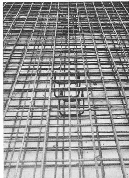
Fig. 3. — Armature de la dalle inférieure. On remarque le décalage des trois nappes.
