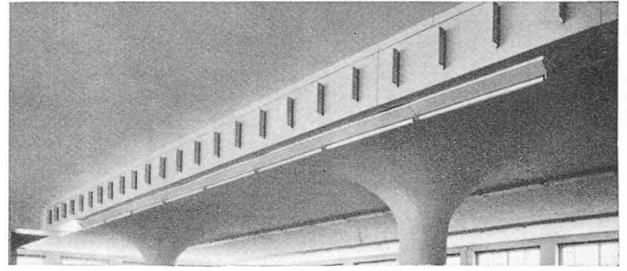
Fig. 9. — Canal à fentes installé dans une usine textile.
