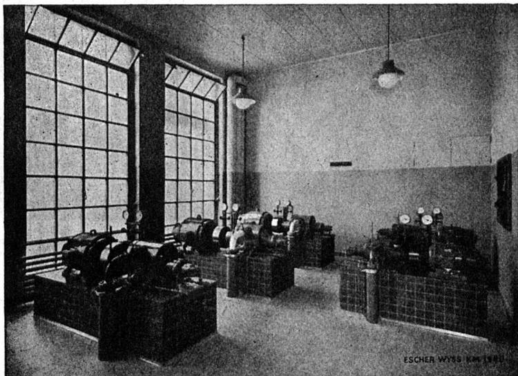
5 compresseurs «ROTASCO» pour la réfrigération
