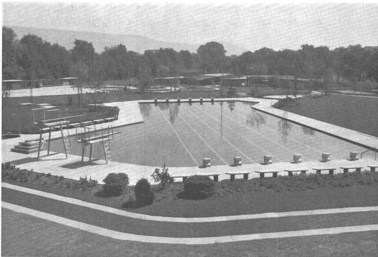
Piscine d'Aarau. L'installation de filtrage et de pompage équipée de crépines Micafil se trouve sous le hall d'entrée. (Voir page 356 article « Crépines pour installation de filtrage rapide. »)
