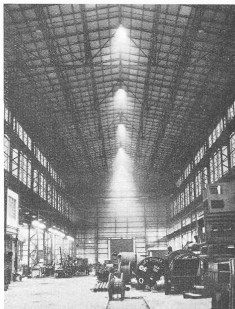
Fig. 5. — Eclairage d'un grand hall par lampes à ballon fluorescent sous réflecteurs profonds.
