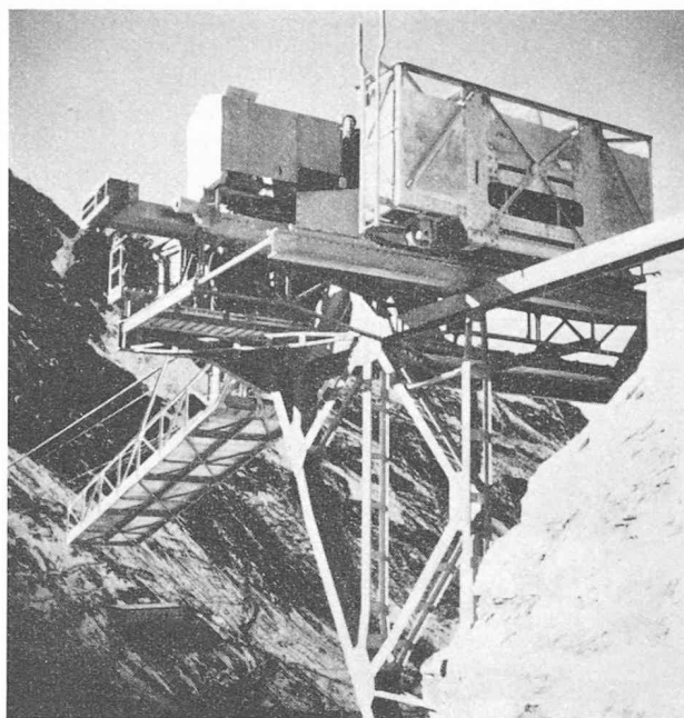
Fig. 5. — Pont 1 de Mauvoisin avec le chariot d'ancrage.
