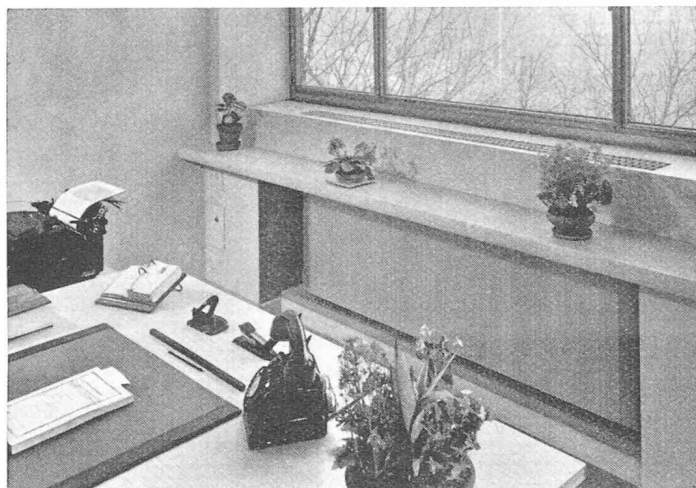
Fig. 7. — Disposition d'un appareil « Jettair » dans un bureau.
