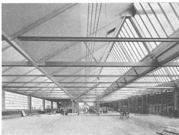
Fig. 14. — Fabrique de Produits Firestone, Pratteln. Nouvel agrandissement sans colonnes intermédiaires. Ingénieur : H. Bargetzi, dipl. E.P.F., Bâle.
