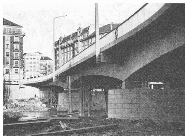
Fig. 4. — Pont sur l'Arve, à Genève (1956-1957).
