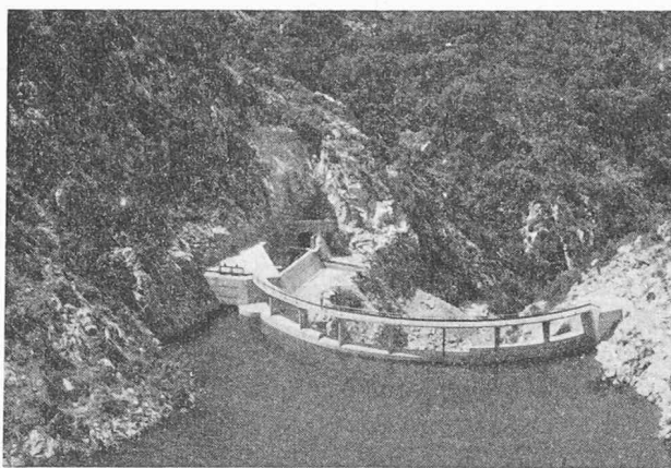
Fig. 3. — Départ de la branche mère et la retenue du contre-barrage de Bimont.
