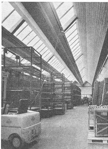
Fig. 6. — Voile mince plissée précontrainte de 36 m de portée (Siemens-Zurich).
