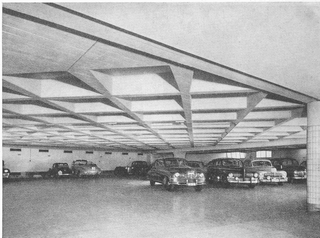
Fig. 3 b. Modèle réduit à l'échelle 1 : 40. Réseau de barres en métal léger de 5 \times 5 cm.
