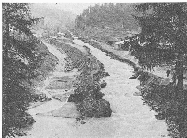
Fig. 12. — Vue du chantier, août 1956. (Photo Brügger, Zurich)
