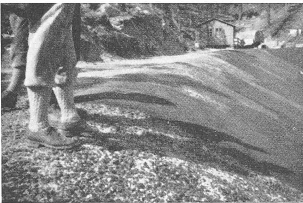
Fig. 15. — Exécution de la sous-couche en gravier 17-35 avec pénétration de 2 kg/m 2 de bitume. Au second plan, pose de la première couche du tapis bitumineux.
