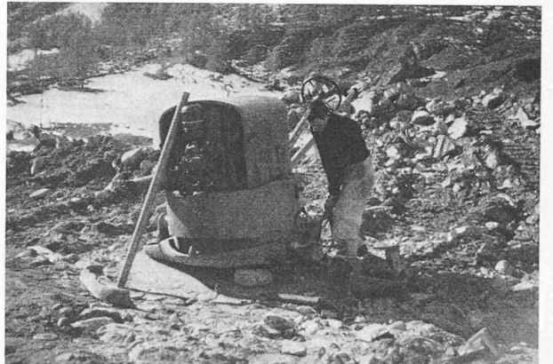
Fig. 8. — Vibrateur « Vibromax » — Démontage des plaques latérales pour réduire la surface d'action.
