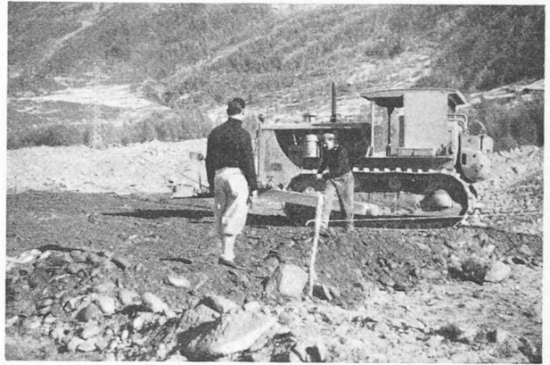
Fig. 5. — Mise en place d'une couche de 40 cm au moyen du bulldozer. La teinte plus foncée des matériaux remués dénote une humidité naturelle du matériau. Des blocs jusqu'à environ 40-50 cm de \varnothing sont compris dans le matériau répandu.
