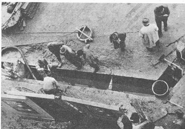
Fig. 7. — Paroi en fouille constituant l'enceinte d'une excavation pour passage sous chaussée à Lucerne.
