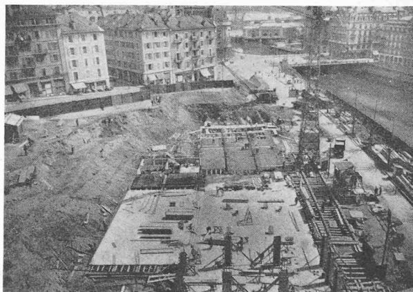
Fig. 1. Vue d'ensemble des fondations en cours d'exécution.
