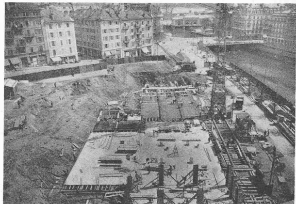
Fig. 1. Vue d'ensemble des fondations en cours d'exécution.
