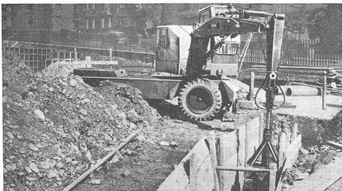
Modèle 154: contenance de la benne 1500 l, convertisseur de couple, inverseur de direction, essieux à engrenages planétaires, renversement vers l'arrière de la benne à proximité du sol: gaspillage minime, bras de levage de forme arquée (breveté) pour une sécurité accrue du conducteur.
