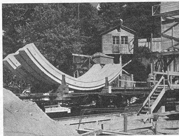
Fig. V/6. — Transport des voussoirs, par anneau complet sur wagon de chemin de fer.
