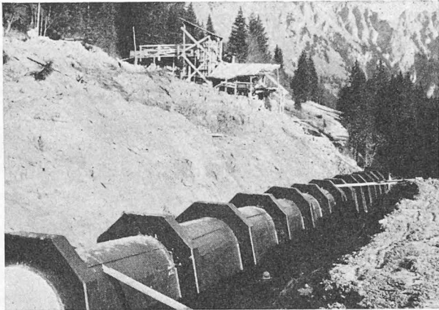
Photo n° 2. — Galerie de l'évacuateur de crues.
