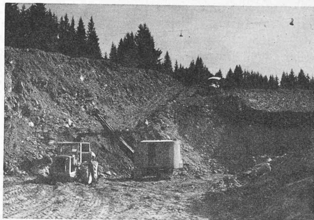
Photo n° 7. — Vue de la zone d'emprunt des terres.
