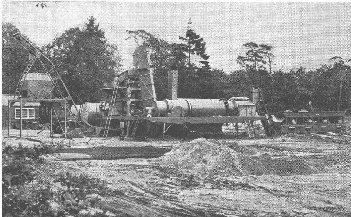
Poste d'enrobage type 1000 SB, capacité 38 à 45 t/h
