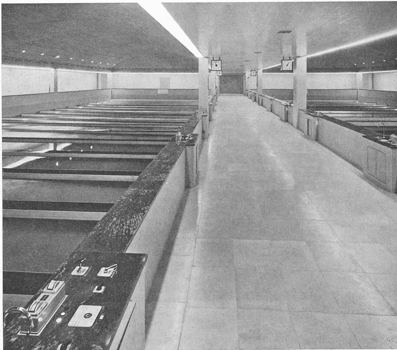
Fig. 8. — Vue générale de la salle des filtres ; des deux côtés de la galerie centrale, on distingue les pupitres de commande.
