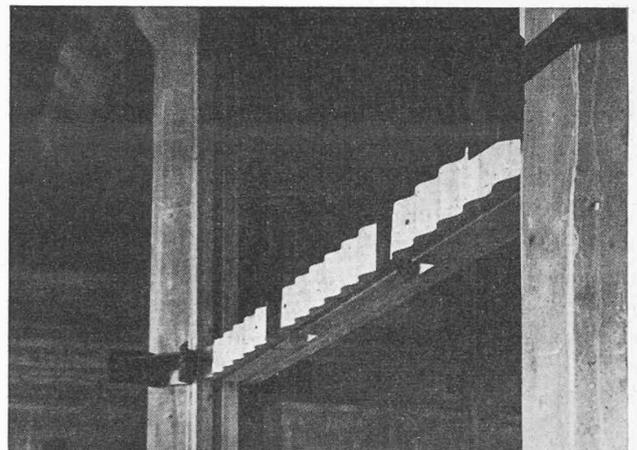
Fig. 2. — Vue de la poutre-moise en montage.
