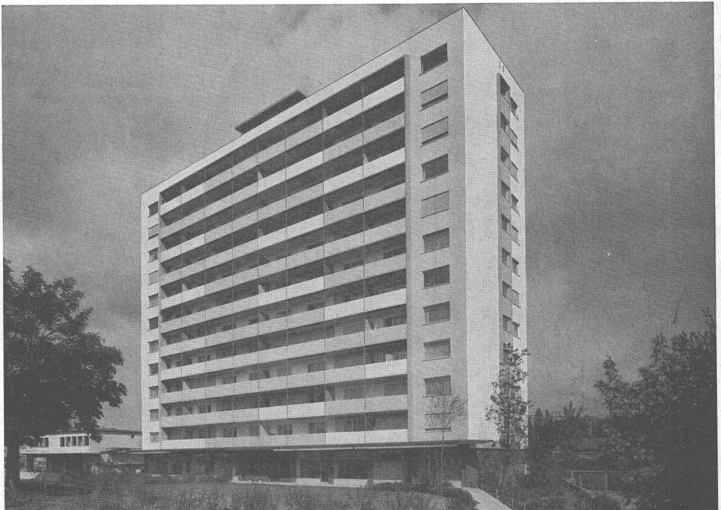
Immeuble-tour « Kreuzmatte » à Zollikofen-Berne, exécuté en maçonnerie Durisol, fournie par la Durisol, Matériaux de construction légers S.A., Dietikon-Zurich.
