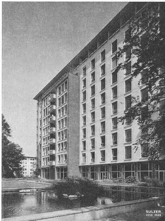
Fig. 10. — Nouveau bâtiment des malades de l'Hôpital cantonal de Winterthour, équipé d'installations de climatisation et de chauffage par rayonnement Sulzer.
