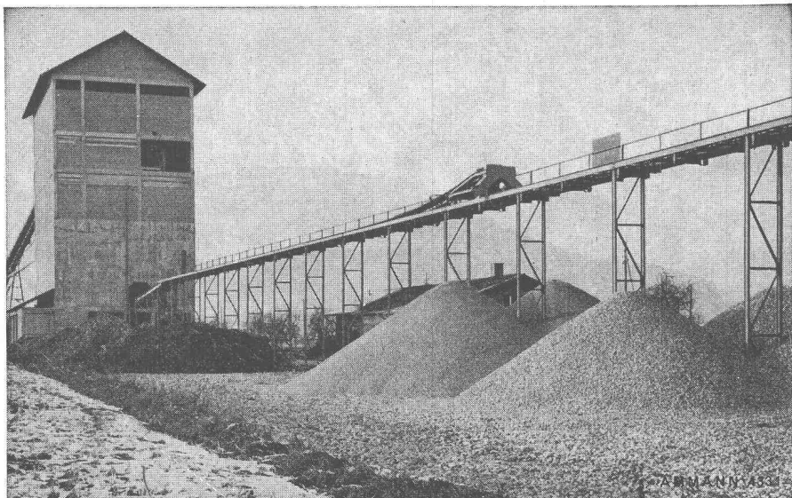
Transporteur à ruban installé dans une carrière et muni d'un chariot de déversement qui permet d'entasser les différentes composantes à l'endroit voulu de part et d'autre du ruban.
