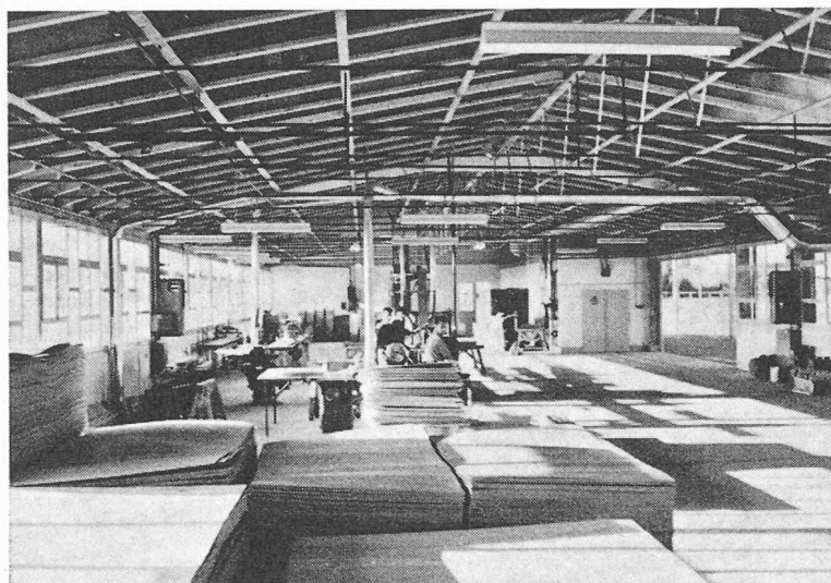
Fig. 2. — Vue intérieure de l'usine Wellsteg, à Domdidier.
