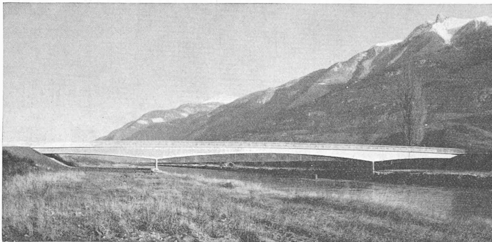
Fig. 6. — Vue du pont terminé.
